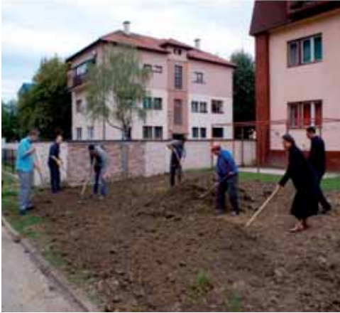
Насипање хумусом и засијавање парковском травом
