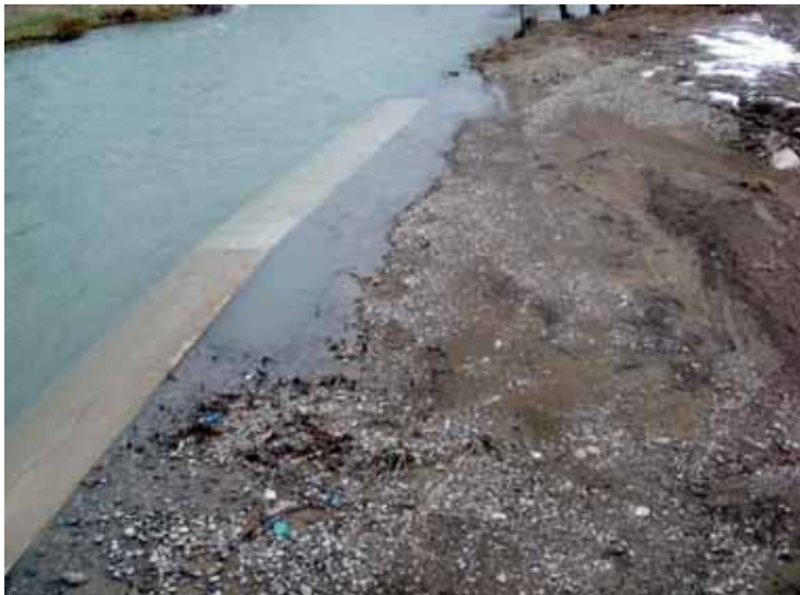
Санација и реконструкција градског моста у Челинцу
