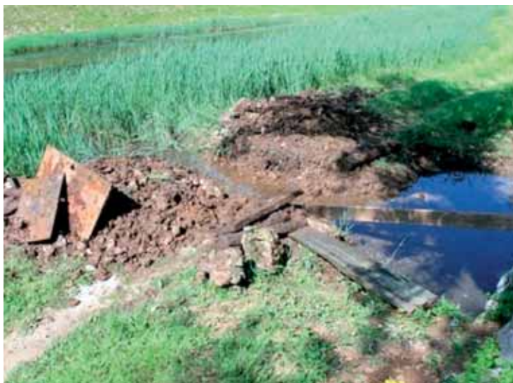
Чишћење изворишта и канала ријеке Врело
