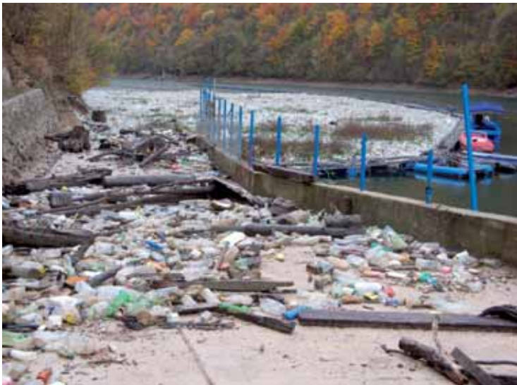
Стање прије постављања нове заштитне мреже у еко центру – језеро Бочац
