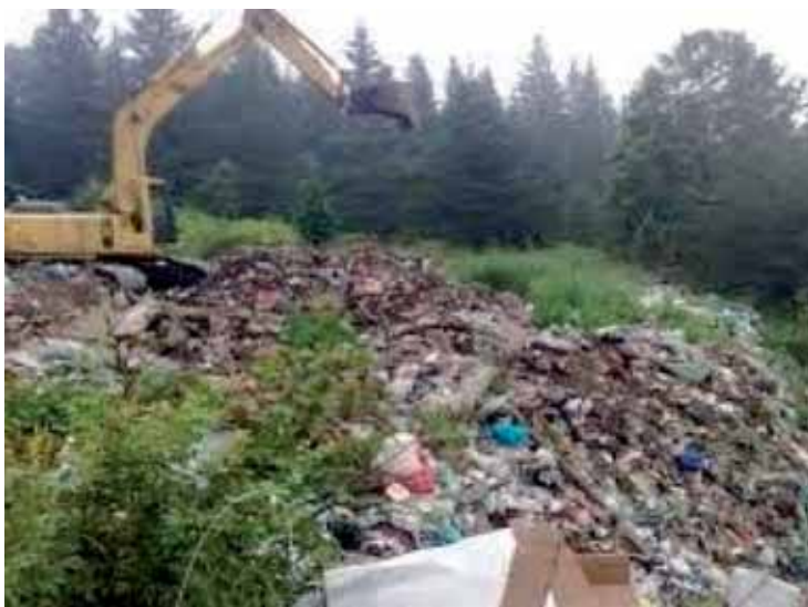
Уклањање отпада (општина Невесиње)
